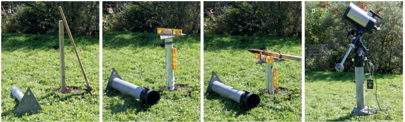
▲ Abb. 4: Verschiedene Stufen der Montage einer Fundamentschraube: Vorbohren des Lochs durch Einschlagen eines Pfostens (a), Eindrehen der Fundamentschraube mittels eines Hebels (b, c), Installieren von Säule und Teleskop (d).
