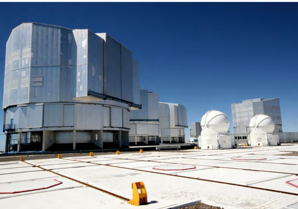
Abb. 6: **Das Schienennetz** und mögliche Positionen für die 1,8m-Hilfsteleskope für die Interferometrie. Die Hilfsteleskope können alleine oder in Verbindung mit den VLT-UTs eingesetzt werden. Im Hintergrund die vier 8,2m Hauptteleskope Antu, Kueyen, Melipal und Yepun.
