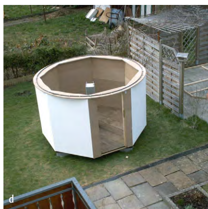
Abb. 2: Sternwartenbau Schritt für Schritt: a) Die Löcher für das Fundament sind ausgehoben. b) Der Holzboden ruht auf einem Gerüst aus 10cm starken Balken. c) Das Lattengerüst wird mit Wandplatten verkleidet. d) Die Lauffläche für die Rollen mit dem Stahlring wird angebracht, der ein verrutschen der Laufrollen nach außen verhindern soll. Der Unterbau wird fertig lackiert, die Innenwände werden später schwarz gestrichen. e) Das Gerüst der Kuppel wird angepasst und danach für die Deckenmontage abgenommen. f) Die Seitenwände sind montiert und die Dachluke ist ebenfalls fertiggestellt. Der gesamte Rand der Kuppel wird mit einem Gummiband verkleidet, um Wassereinträge zu verhindern.
