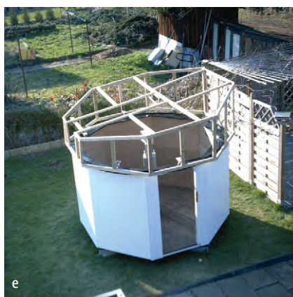
Abb. 2: Sternwartenbau Schritt für Schritt: a) Die Löcher für das Fundament sind ausgehoben. b) Der Holzboden ruht auf einem Gerüst aus 10cm starken Balken. c) Das Lattengerüst wird mit Wandplatten verkleidet. d) Die Lauffläche für die Rollen mit dem Stahlring wird angebracht, der ein verrutschen der Laufrollen nach außen verhindern soll. Der Unterbau wird fertig lackiert, die Innenwände werden später schwarz gestrichen. e) Das Gerüst der Kuppel wird angepasst und danach für die Deckenmontage abgenommen. f) Die Seitenwände sind montiert und die Dachluke ist ebenfalls fertiggestellt. Der gesamte Rand der Kuppel wird mit einem Gummiband verkleidet, um Wassereinträge zu verhindern.
