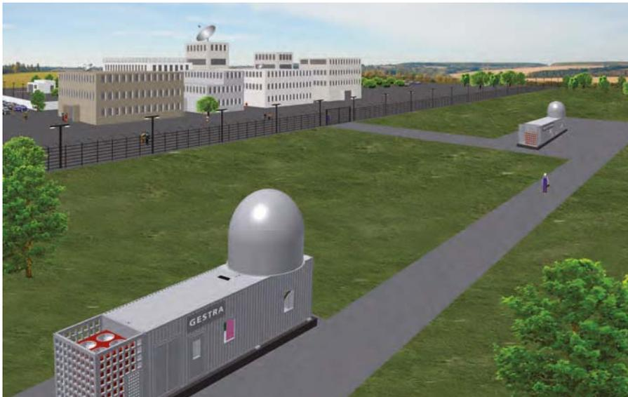
▲ Abb. 4: Das German Experimental Space Surveillance and Tracking Radar (GESTRA) besteht aus einem Sendesystem und einem Empfangssystem mit integrierter Datenauswertung.
